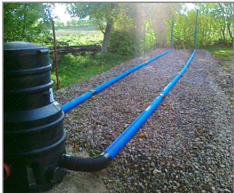
Bild på en infiltrationsanläggning.
