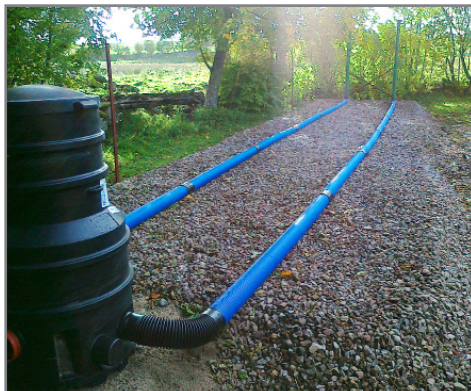
Bild på en infiltrationsanläggning.
